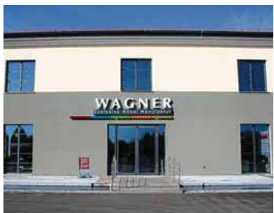
Der Eingang an der Südseite des neuen Gebäudes: Über eine kleine Brücke gelangt man zur Tür.
