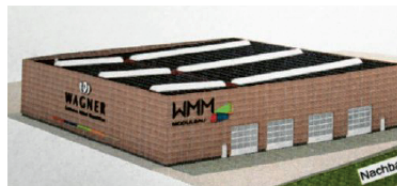
So soll die Fertigungsanlage im Leitschäcker in Illertissen einmal aussehen. Der Bau hat bereits begonnen. Foto: WMM AG/Waltl
